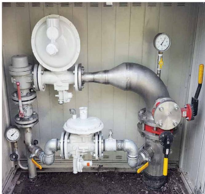
Rénovation de l'un des 200 postes de détente sur le réseau de Cosvegaz SA par l'adjonction d'une deuxième ligne de détente.
