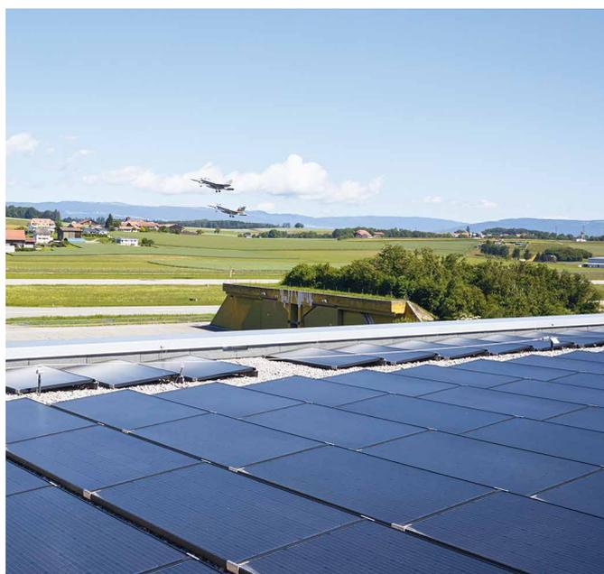
Installation solaire photovoltaïque de plus de 4'000 m<sup>2</sup> réalisée par Agena SA sur le toit de Speedwings, à Payerne. La production électrique équivaut à la consommation moyenne annuelle de près de 230 ménages.
