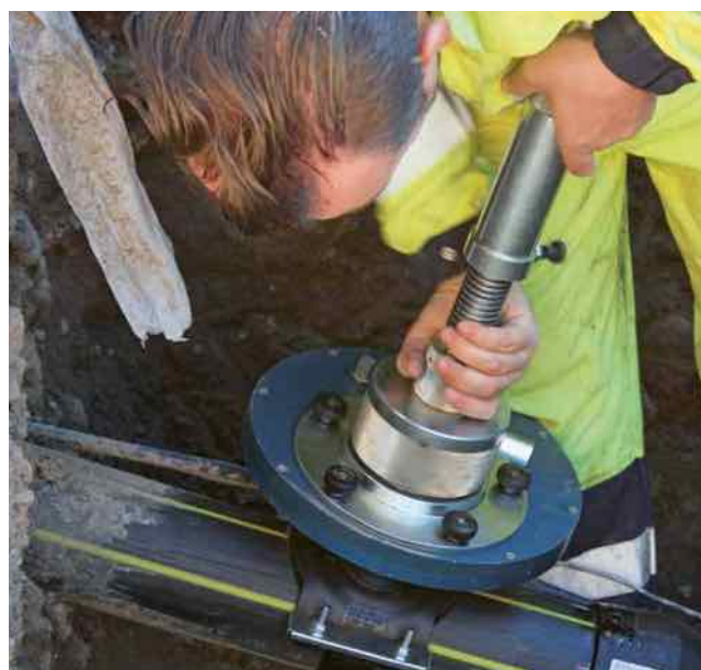
Installation de nouvelles conduites de gaz naturel à Glutières, sur la commune d'Ollon.
