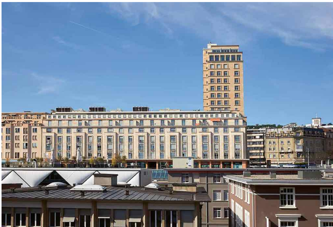
Les sociétés Joseph Diémand, Brauchli et Roos Ventilation ont participé à la rénovation de toutes les installations sanitaires, de chauffage et de ventilation de la tour Bel-Air, à Lausanne.
