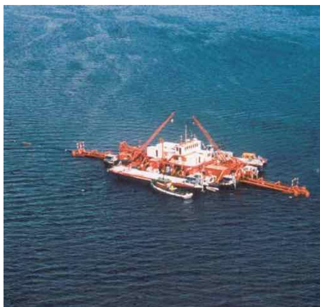
Pose du premier gazoduc de Gaznat au fond du Léman en 1974 permettant d'acheminer le gaz naturel depuis Bex jusqu'à Vernier.
