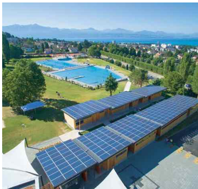
Installation solaire photovoltaïque réalisée sur les toits de la piscine de la Fleur-de-Lys, à Prilly. La production électrique équivaut à la consommation moyenne annuelle de 30 ménages.
