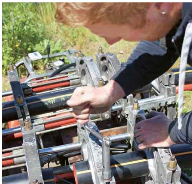
Le réseau de distribution de Cosvegaz a été complété par 5,4 km de nouvelles conduites de gaz naturel.
