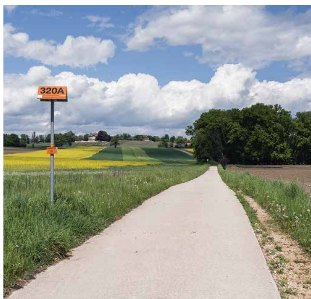
Potelet indiquant le tracé du gazoduc à haute pression de Gaznat dans la campagne vaudoise.
