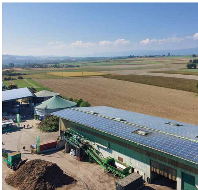
Vue aérienne du site d'Ecorecyclage. Les installations solaires sur les toitures des bâtiments permettent de produire une quantité d'électricité renouvelable équivalente à la consommation moyenne de 70 ménages par an.
