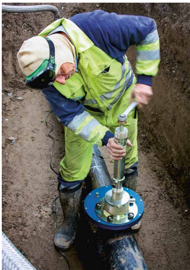
Assainissement d'anciennes conduites de gaz naturel sous le Grand Pont à Aigle.
