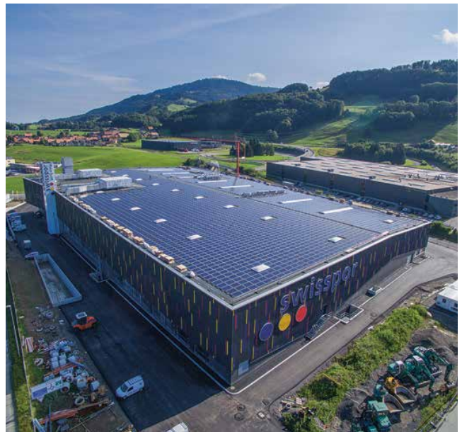
Réalisation d'une installation solaire photovoltaïque de grande envergure sur le toit de swisspor Romandie SA, à Châtel-St-Denis.
