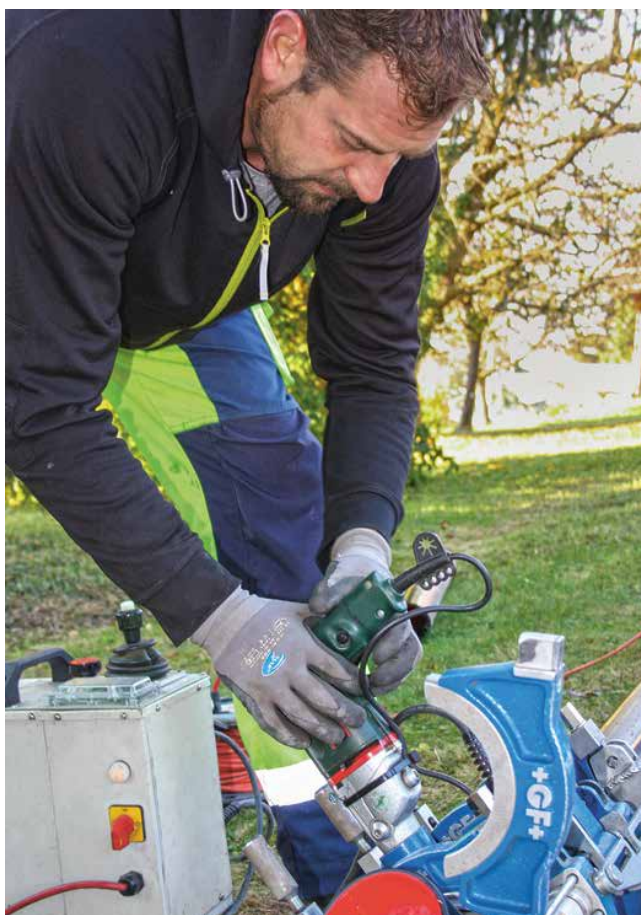
Remplacement d'anciennes conduites de gaz naturel par des tubes en polyéthylène à St-Légier.
