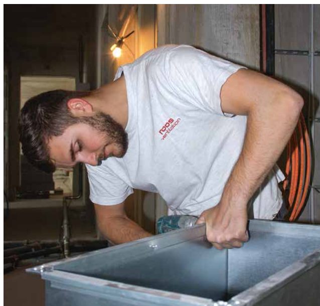
Fabrication de systèmes de ventilation et de rafraîchissement sur mesure pour un centre commercial de Vevey.
