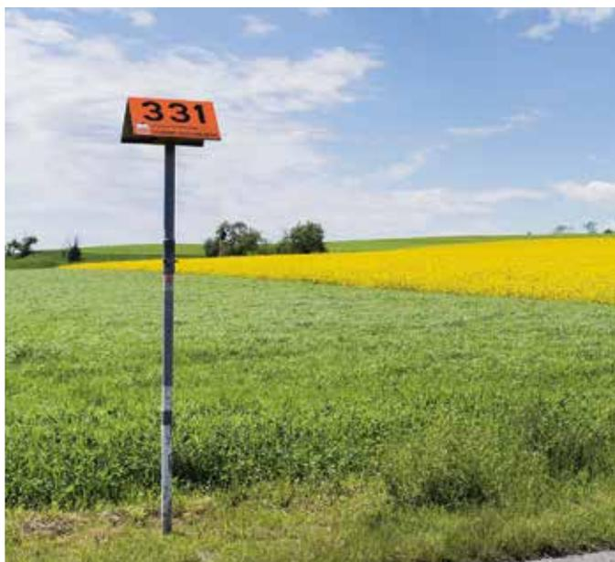
Les potelets de Gaznat jalonnent le tracé des conduites souterraines de gaz naturel à haute pression sur tout le réseau romand.
