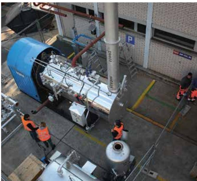
Rénovation des installations de chauffage dans les ateliers industriels des CFF à Yverdon.
