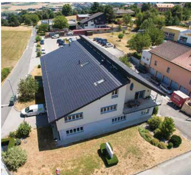
Les deux pans de la toiture du bâtiment de Cosvegaz ont été recouverts par des tuiles solaires photovoltaïques Panotron. Epousant parfaitement les contours du toit, ces tuiles d'origine suisse apportent la même efficacité énergétique qu'une installation solaire photovoltaïque traditionnelle.
