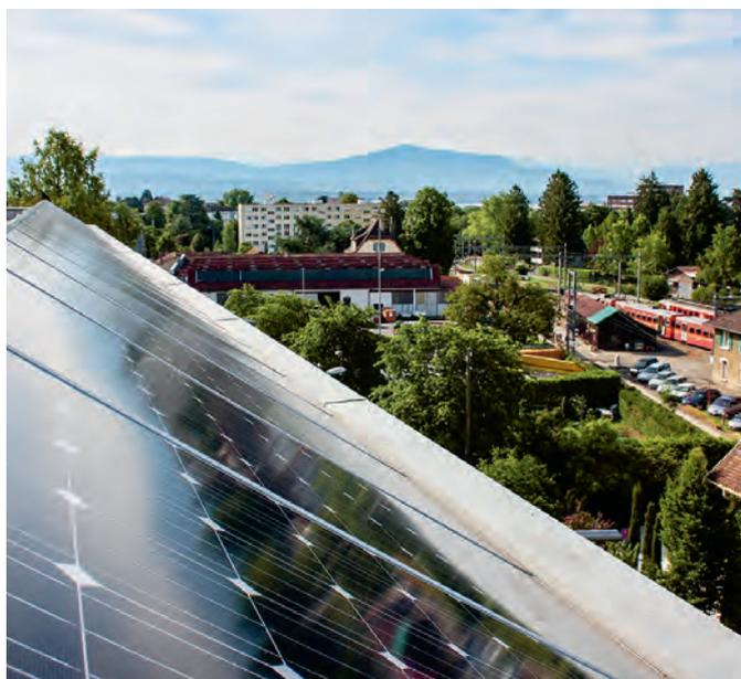
Panneaux solaires thermiques et photovoltaïques installés sur le toit de la Fondation du Midi à Nyon. Par le biais d'une solution avant-gardiste de préparateurs instantanés, l'eau chaude sanitaire n'est pas stockée, mais produite immédiatement, ce qui améliore la qualité de l'eau.
