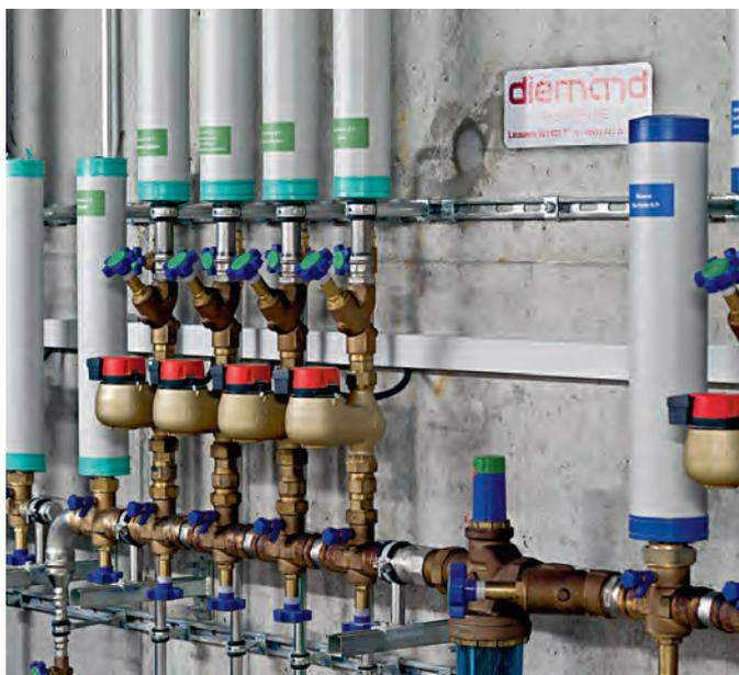
Installation de conduites alimentées par l'eau du lac Léman en vue de rafraîchir un bâtiment sur le site de l'EPFL. Projet réalisé en collaboration avec Brauchli.
